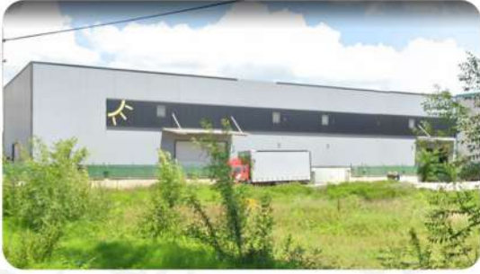
Tem Trafo / KOCAELİ
